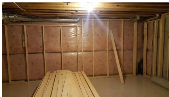
Figura 5. Izolarea termică a subsolului pe partea interioară 7
